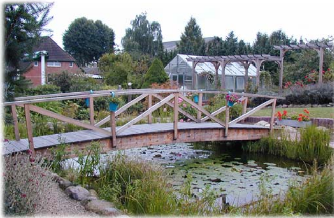
7 Meter lange Brücke über einen Teich aus Lärchenholz, Witzeze
