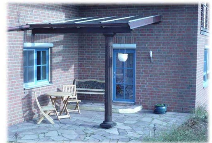
Terrassendach aus Brettschichtholz mit Glasbedachung und Rundsäule, Seitenblende und Rinne aus Kupfer, Farbe Remmers HK-Lasur Palisander, Basedow
