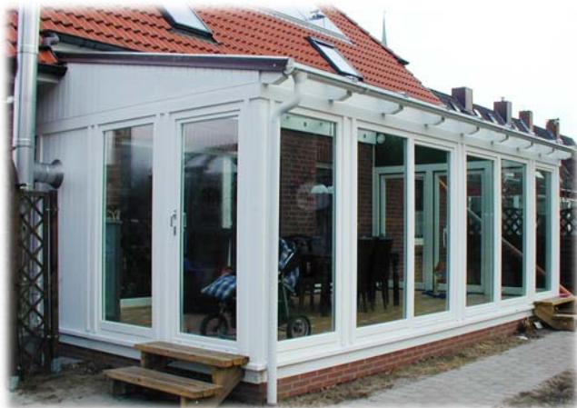
Wintergarten aus Brettschichtholz mit Glasdach, Geesthacht
