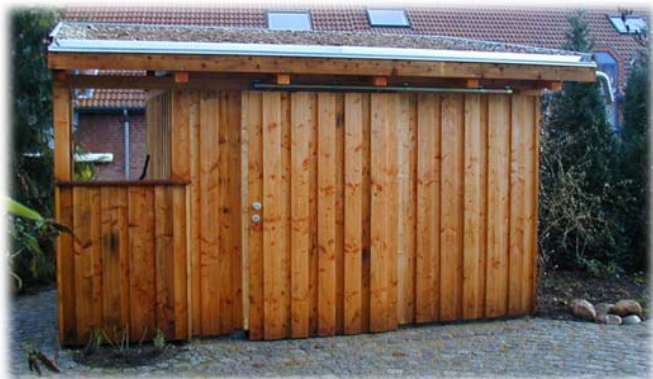
Gerätehaus mit Seitenunterstellplatz, Schiebetür und Grünbedachung, Verkleidung als Boden-Deckelschalung mit Lärchebrettern sägerau, Lüneburg
